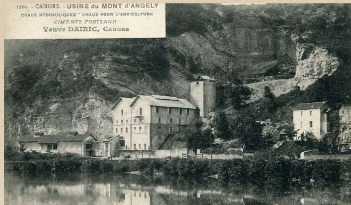
usine de ciment de chaux à Cahors
